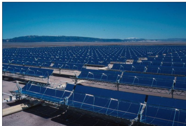
Campo de colectores cilindro parabólicos de la central termosolar en Kramer Junction, California
